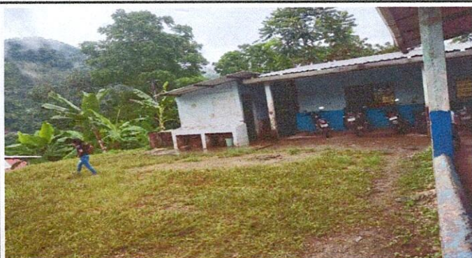
Foto 3: Estructura de techo tipo portico
